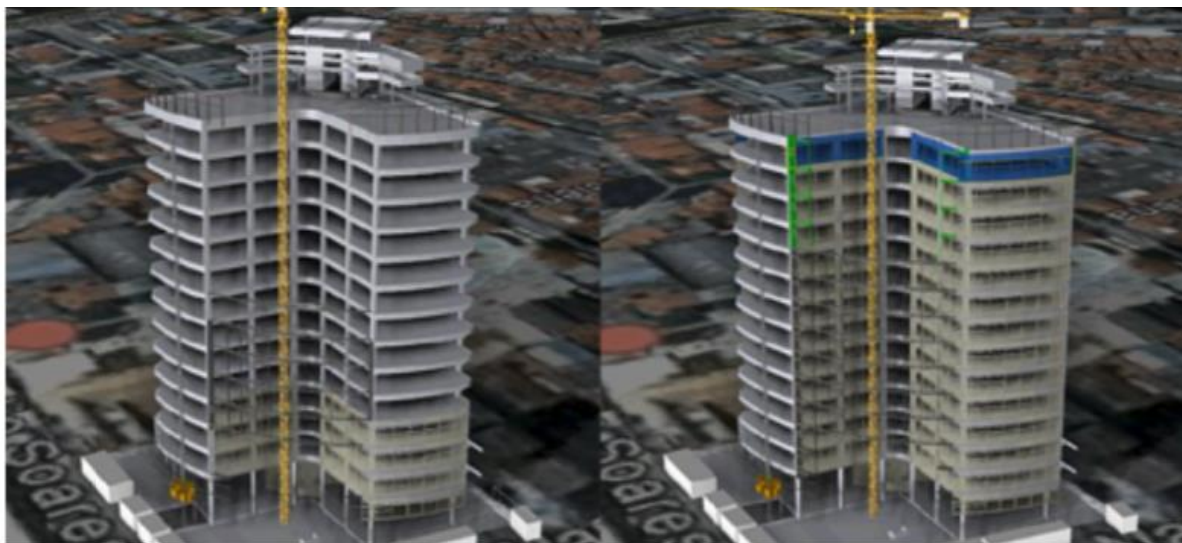
Figura 16: comparativo entre projetado e executado.
