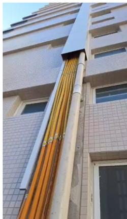
**Figura 20: Infraestrutura de gás e tubulação para cabeamento sob fachada ventilada**
